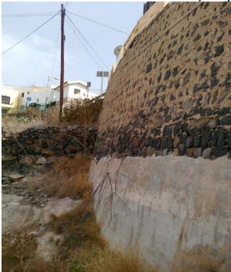
Muro de sostenimiento
